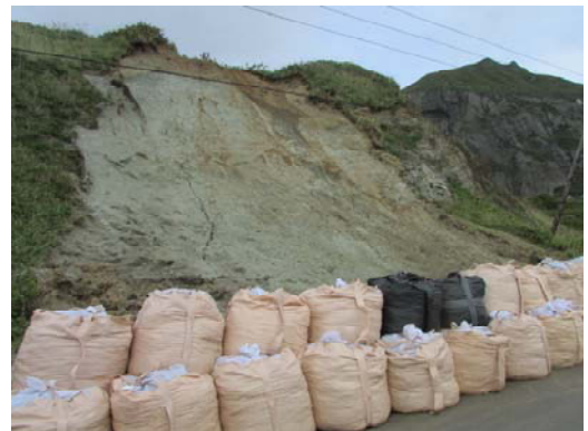
写真-2 元地層における斜面崩壊
