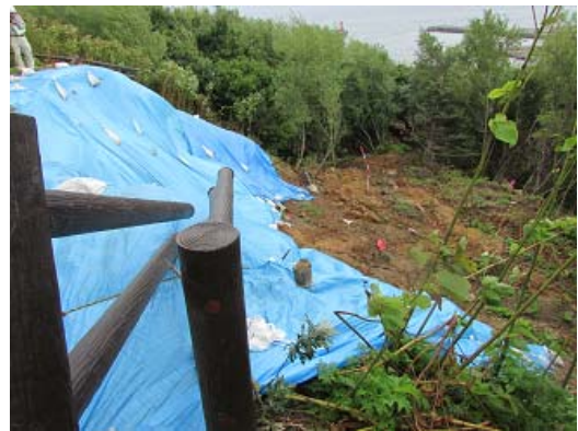
写真-1 礼文小学校付近の斜面崩壊
