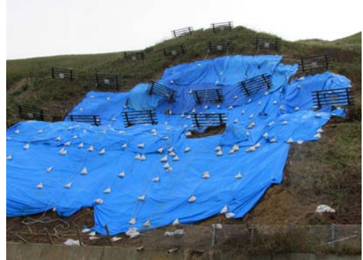
写真-4 船泊高山地区の斜面崩壊後の状況
