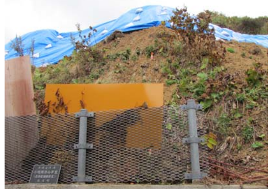
写真-3 津軽地区の対策工実施個所の斜面崩壊
