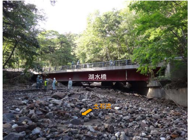
写真-14 湖水橋の桁下空間と下流の土砂堆積状況（下流から撮影）
