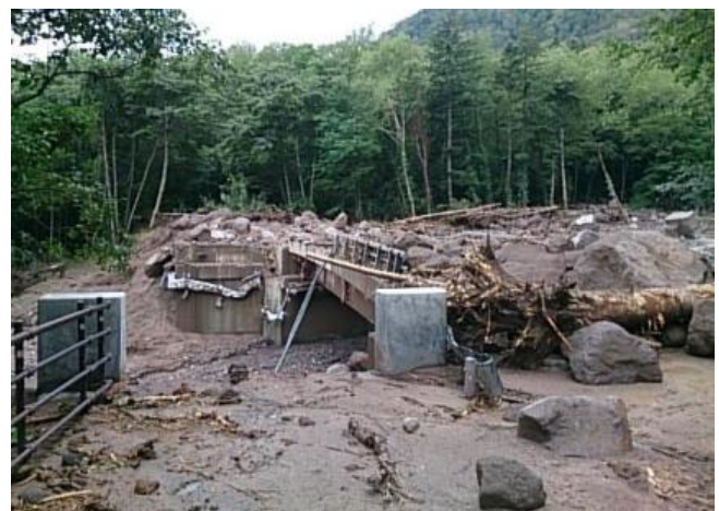
写真－9 丸駒橋の被災状況（9月11日撮影 左側は流失した歩道橋桁部）
