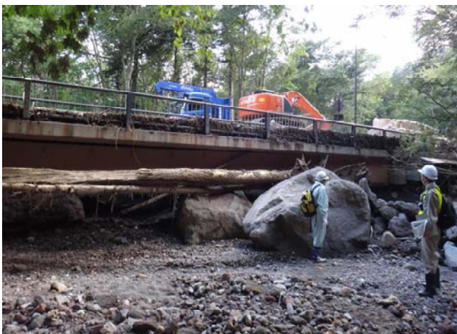
写真-13 湖水橋桁下の土砂堆積状況（上流から撮影）
