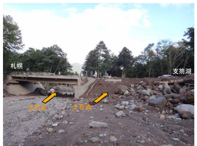
写真－10 上流側から見た丸駒橋の被災状況
