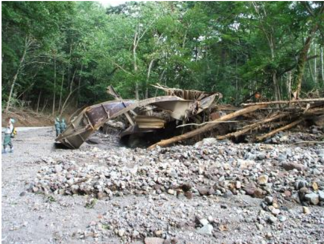
写真-11 流失した丸駒橋の歩道橋桁
