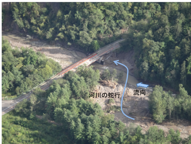
写真－5 河川の蛇行による山水橋右岸の侵食状況
