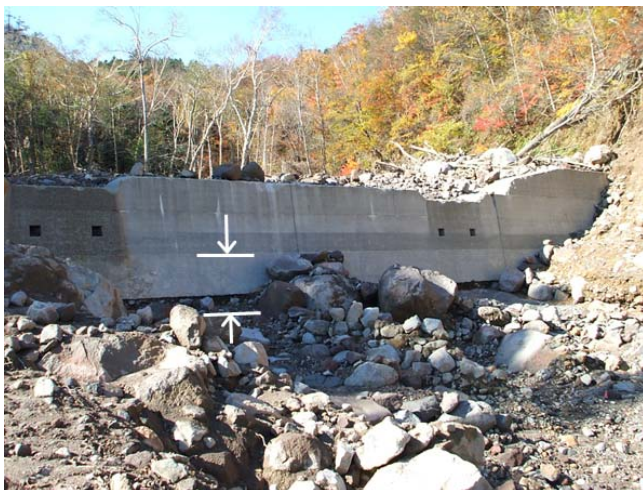
写真－6 下流部が洗掘を受けた治山堰堤
