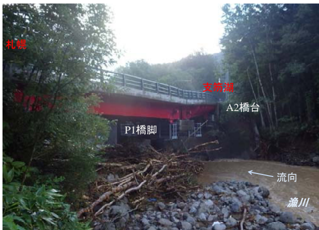
写真－4 奥漁川橋の被害状況
